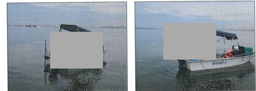
รูปที่ 17 สำรวจค่าระดับพื้นท้องน้ำด้วย ECHO SOUNDING
